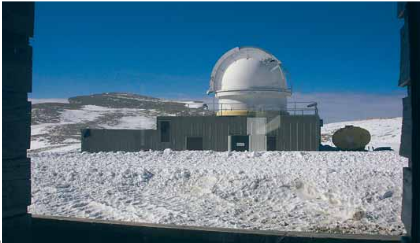
Logé en haute montagne sur un socle de roches calcaires battu par les vents et la neige, le laboratoire du CNRS accueille depuis l'été deux bancs de tests : pour STMicroelectronics, directement impliqué dans le financement du projet (1 million d'euros au total), et l'américain Xilinx.
